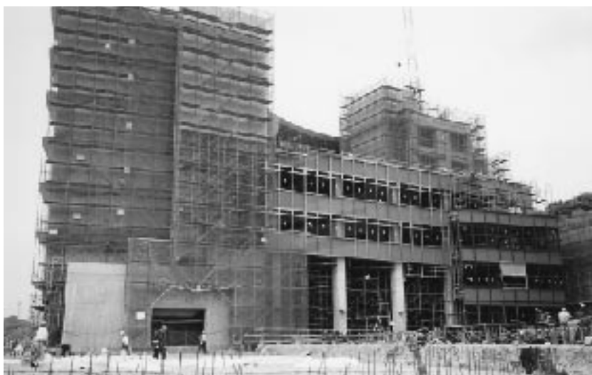
建設中の1番館
